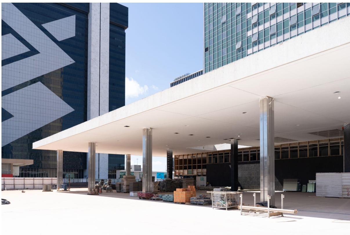
Figura 09 - Marquise do Setor Bancário Sul.
